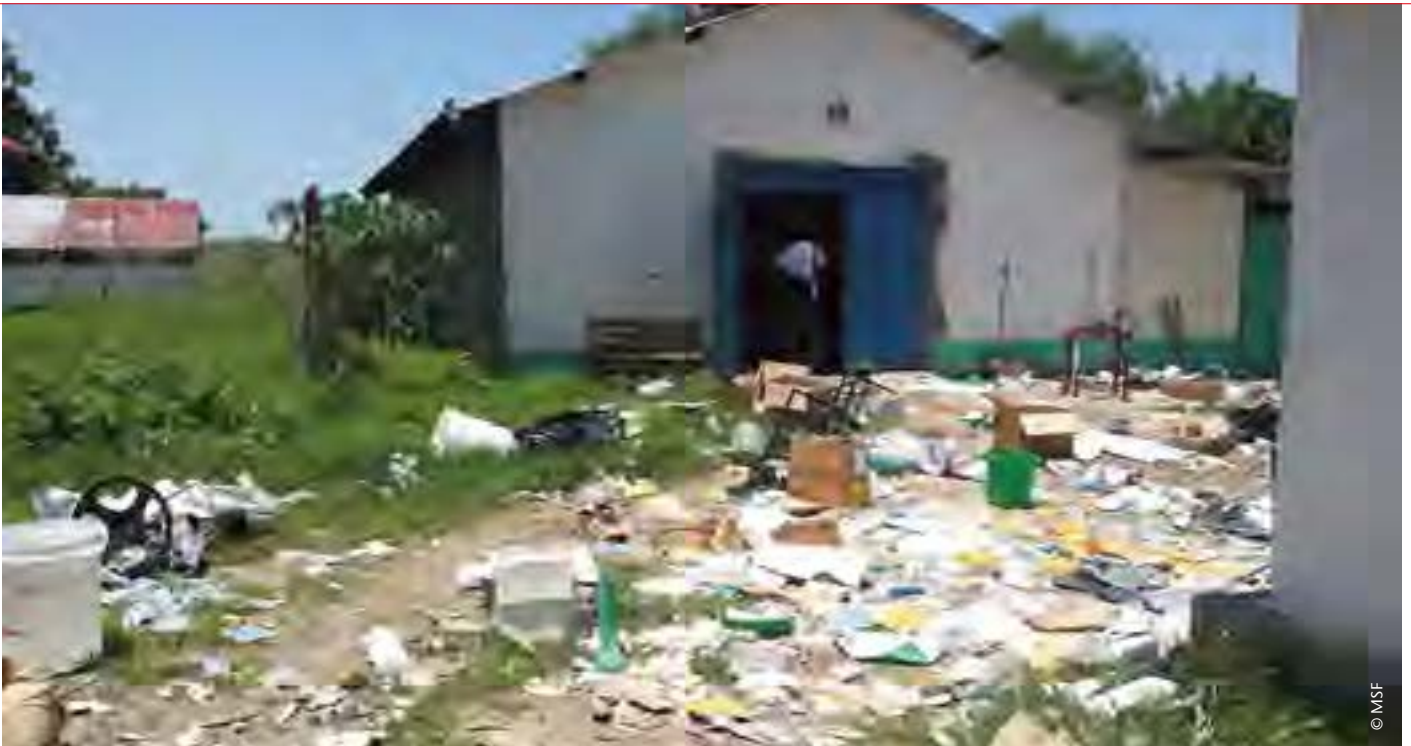
Vista del hospital de MSF en Pibor, destruido intencionadamente para dejarlo inservible.
